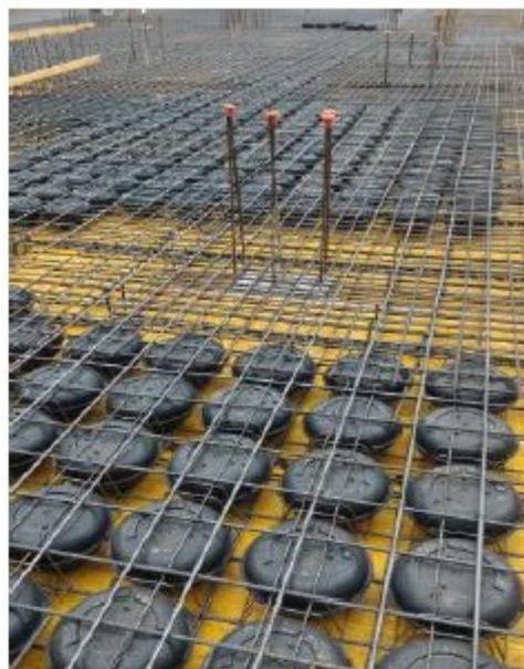
Gli elementi di alleggerimento **ATLAX®** gamma **SLIM-LINE®220** sono di diametro costante 315 mm ed altezza 220 mm. Il corpo cavo è formato da due semigusci di altezza 11 cm e 11 cm assemblati tra loro. Si forma un alleggerimento chiuso che garantisce il totale controllo dell'effettiva quantità di calcestruzzo nel solaio e il suo fluire in maniera omogenea.
