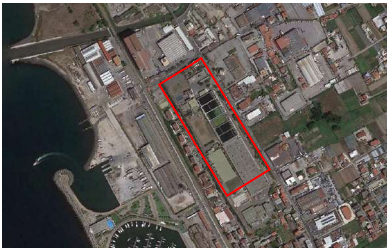
Ubicazione impianto di depurazione in comune di Castellammare di Stabia in sinistra idrografia del fiume Sarno
